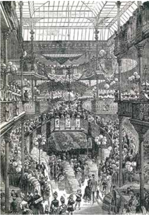
エッフェルが発案した鉄骨構造を用いたボンマルシェ百貨店の中央階段とガラス屋根
